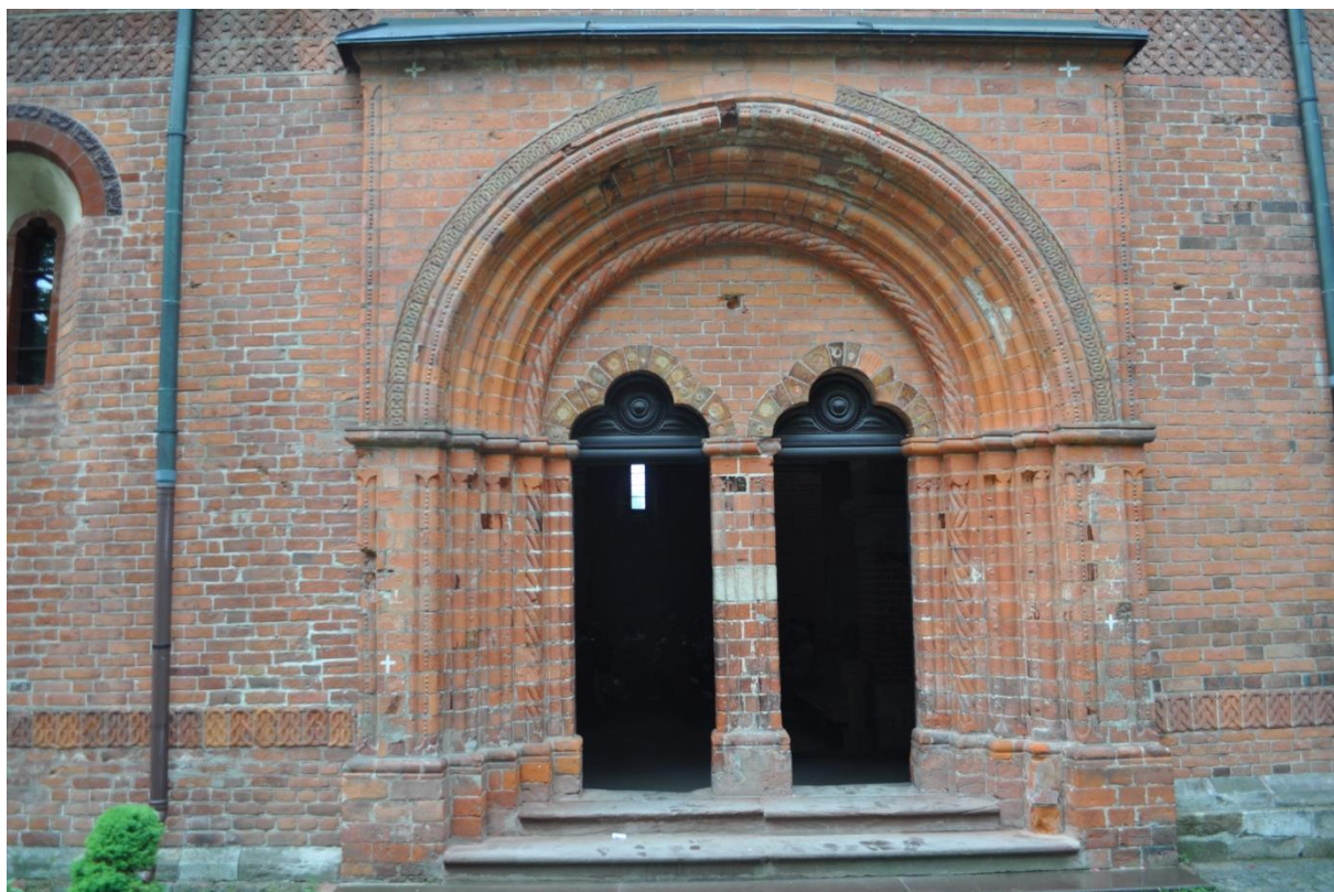
Fot. C. Jastrzębski. Klasztor dominikanów w Sandomierzu powstał jako jedna z pierwszych sakralnych budowli ceglanych
